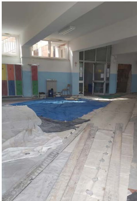
Scuola Media Gabellini - Lavori abbattimento barriere architettoniche.
